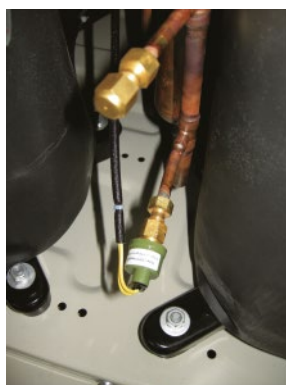
Реле высокого давления
